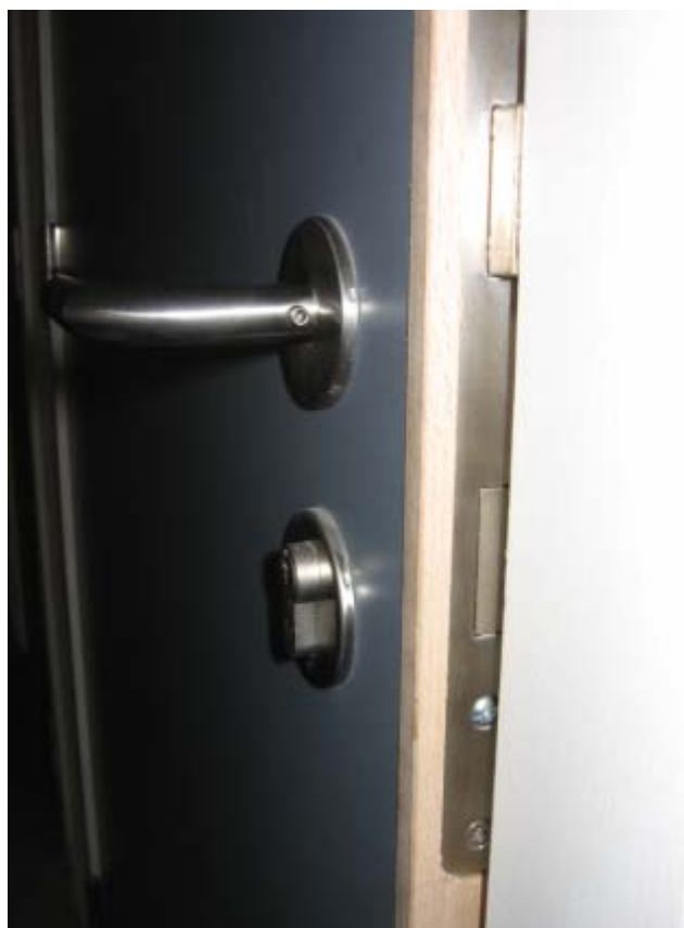
compartimenteringsdeur sluit niet volledig
