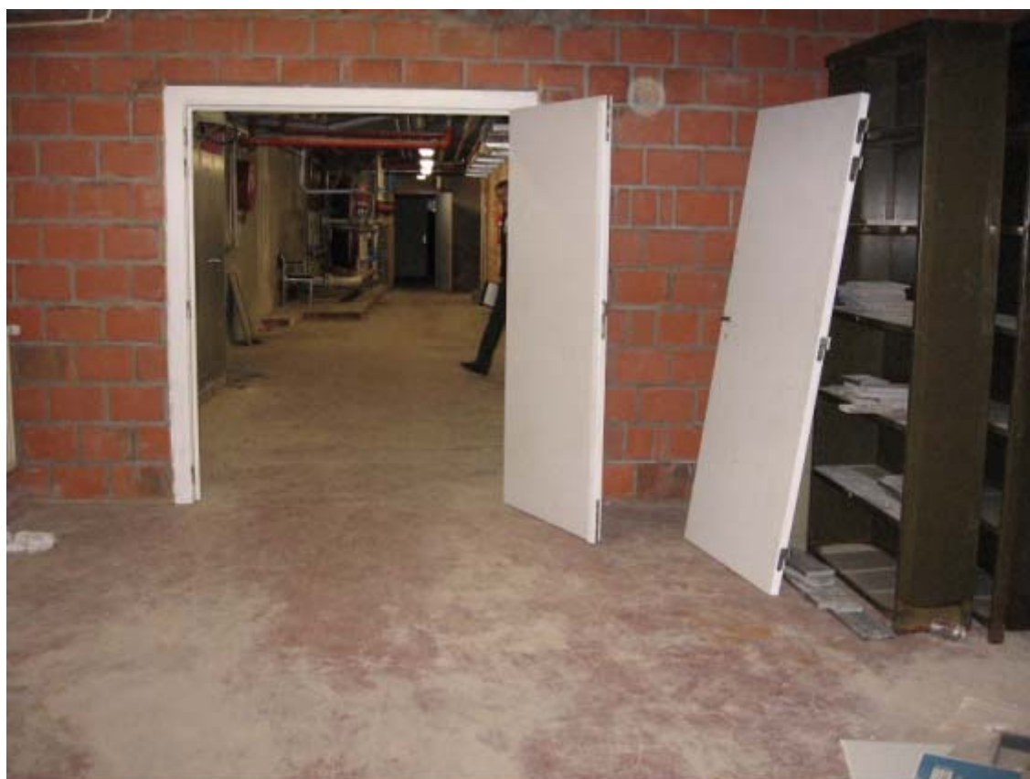
compartimenteringsdeur sluit niet volledig
